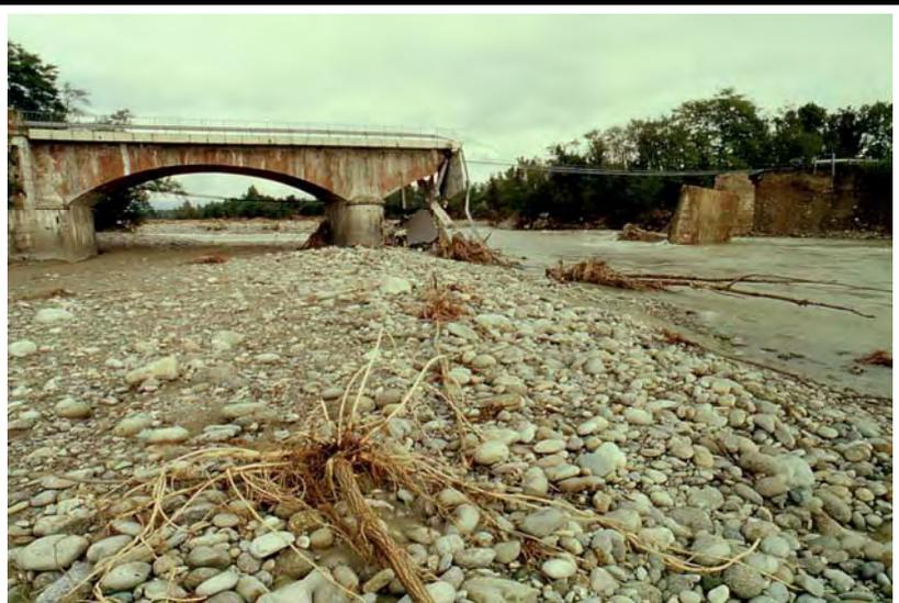
**Fig. 2.45** - In occasione delle più intense manifestazioni idrometeorologiche si possono verificare gravi fenomeni di dissesto idrogeologico. In questa immagine si osserva un ponte autostradale sul torrente Malone (in provincia di Torino) in gran parte "spazzato" dall'alluvione del 1992.
