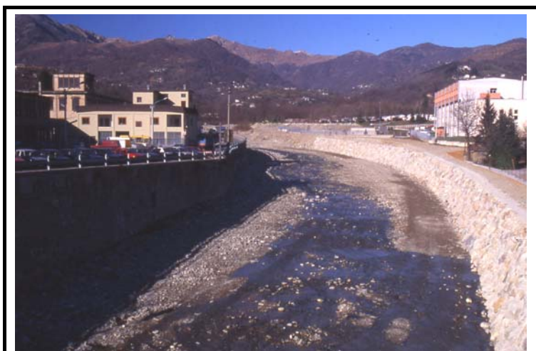
Fig. 1.11 - Un torrente "cementificato", dopo un intervento di sistemazione idraulica. Le sponde sono lisce pareti, incapaci di opporsi, per attrito, al flusso dell'acqua. La corrente, in occasione delle manifestazioni di piena, risulta pertanto più veloce e quindi più pericolosa per la sua maggiore energia erosiva.
