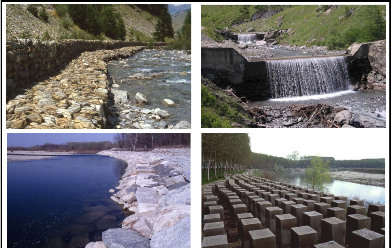
Fig. 1.56 - In alto a sinistra una "gabbionata" (insieme di "gabbie" di ferro riempite di ghiaia grossolana) sistemata a difesa di una sponda sottoposta ad erosione. In alto a destra una briglia in cemento. In basso a sinistra una massiciata (insieme di massi giustapposti e talora con interstizi cementati). In basso a destra un insieme di prismi (blocchi di cemento a forma di parallelepipedi) disposti lungo la riva e pronti per essere calati sulla sponda per la realizzazione di una "prismata".
