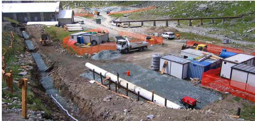
**Fig. 12** - Condizioni dell'area del **cantiere 2**, destinato allo stazionamento dei macchinari, agli alloggiamenti degli operai e interessato dallo scavo della trincea per l'ultimo tratto della nuova condotta forzata immediatamente a monte della centrale di Dietro la Torre.
