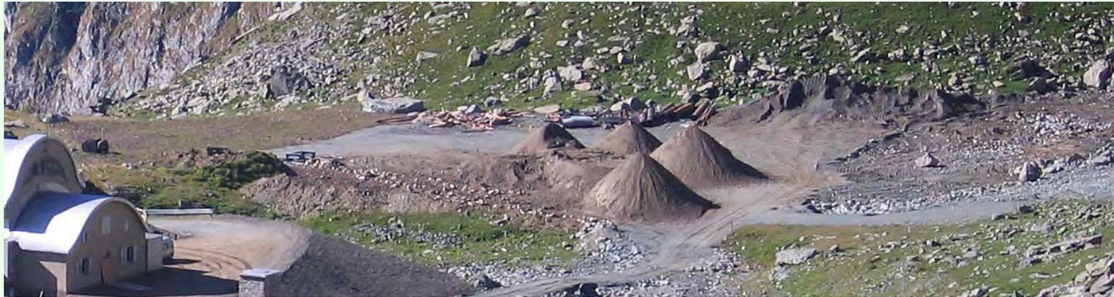
Durante le attività di cantiere in tale sito venivano anche preparati i materiali per la ricostituzione dei suoli nelle aree destinate al recupero. Una parte di essi sono stati utilizzati per il ripristino dello stesso sito.
