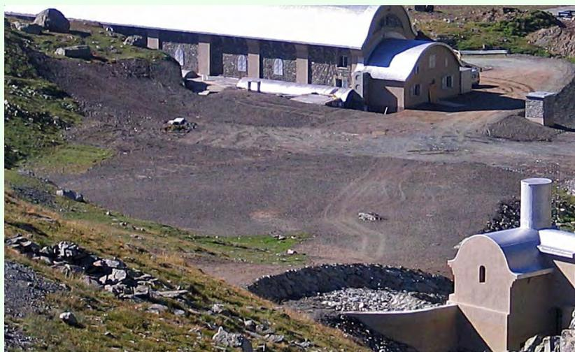
Cantiere a ridosso dell'edificio della centrale di Dietro La Torre. Era interessato dallo scavo della trincea della porzione terminale della condotta ed utilizzato per la rimessa dei veicoli di trasporto e dei mezzi di scavo.
