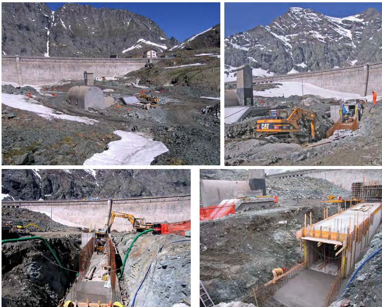
**Fig. 19** - In alto a sinistra è il **cantiere 6** all'inizio delle attività, subito dopo la fusione delle nevi nel 2007. In alto a destra si osserva l'azione dello scavatore che fu smontato a pezzi, trasferito con la teleferica e rimontato nell'area di fronte alla diga del Lago della Rossa. In basso due momenti delle attività legate alla connessione con la condotta forzata che, immediatamente a valle prosegue, con andamento sub-verticale, nella galleria.
