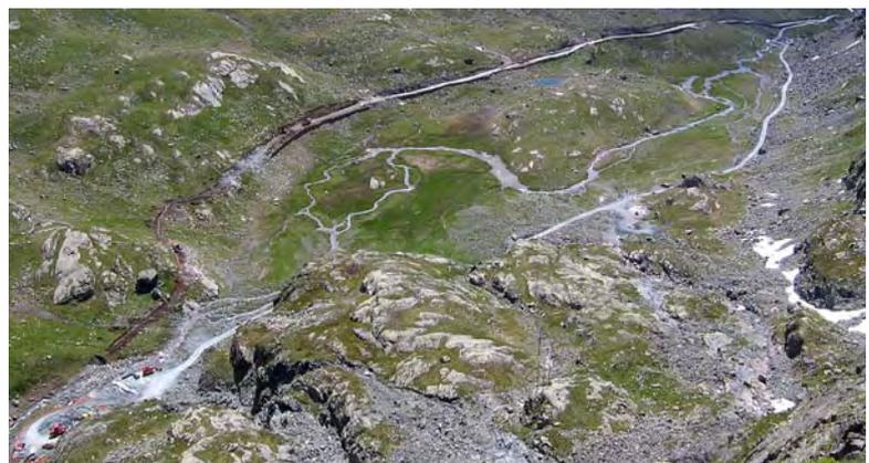
**Fig. 13** - Il **cantiere 3** era una lunga (~ 1,2 km) fascia di terreno larga 6 ÷ 8 m, interessata dallo scavo della trincea nella quale è stata collocata la condotta forzata lungo il tratto dalla galleria alla centrale di Dietro la Torre (**fig. 10**). Nelle due immagini (soprattutto in quella panoramica di destra ripresa dall'alto nel 2010) risulta piuttosto evidente l'impatto paesaggistico sul versante orografico sinistro del rio Gurie.
