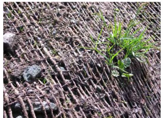
**Fig. 33** - La porzione terminale dell'area del **cantiere 3** (ubicazione in **fig. 10**), immediatamente a monte della centrale di Dietro la Torre, sulla sinistra del rio Gurie, è caratterizzata da una forte acclività. Per tale ragione è stato necessario predisporre delle reti biodegradabili di contenimento dell'erosione dalle acque di ruscellamento e procedere all'idrosemina per favorire una veloce ricolonizzazione vegetale.
