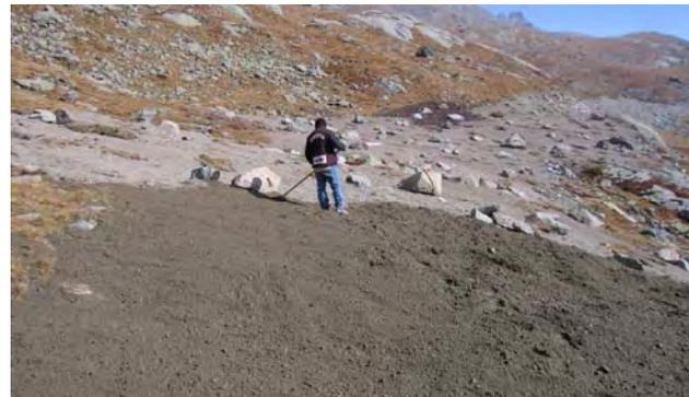
**Fig. 35** - Allo scopo di garantire la migliore lavorazione del terreno ammendato e riportato a copertura delle aree ripristinate sotto il profilo morfologico è stato necessario anche il lavoro manuale con ampio uso di pale e rastrelli.
