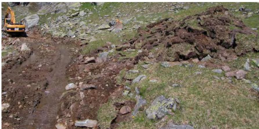
**Fig. 28** - Durante le operazioni di scavo per la costruzione della pista di servizio lungo il **cantiere 3** sulla sinistra del rio Gurie, veniva effettuato lo scotico.
