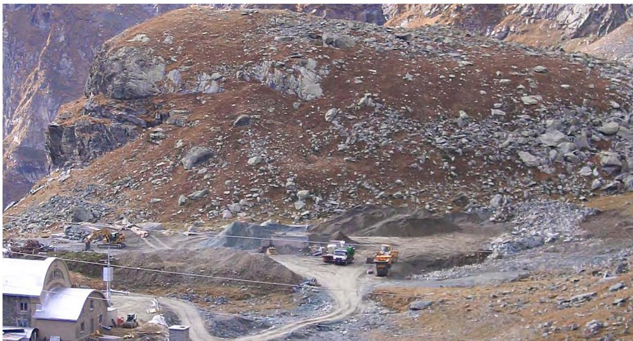
**Fig. 11** - Condizioni dell'area del **cantiere 1**, destinato allo stoccaggio e alla lavorazione dei materiali in fase di piena attività (ubicazione in **fig. 10**). La maggior parte dei materiali in lavorazione erano costituiti da quelli destinati alle coperture per i ripristini ambientali. Tale cantiere è stato smobilitato e ripristinato verso il termine dell'estate 2009.
