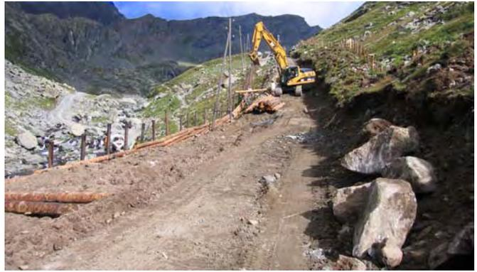
**Fig. 14** - Operazioni di scavo per la realizzazione della pista di servizio per il collegamento tra le aree dei **cantieri 1** (presso la centrale di Dietro la Torre) e **4** (accesso alla galleria).
