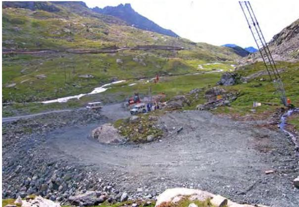
**Fig. 18** - In alto è illustrato il sito della stazione di partenza della teleferica utilizzata per il trasporto dei materiali destinati al **cantiere 6** (quello più alto, in prossimità della diga del Lago della Rossa). La teleferica è stata utilizzata anche per il trasporto di un grosso escavatore smontato in pezzi e rimontato presso la stazione di arrivo, rappresentata a lato.
