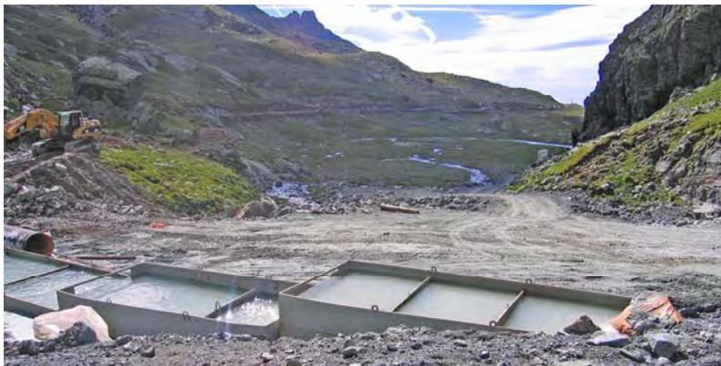
**Fig. 21** - Vasche di decantazione in successione sistemate presso l'area del **cantiere 4** per evitare l'intorbidimento delle acque del rio Gurie.
