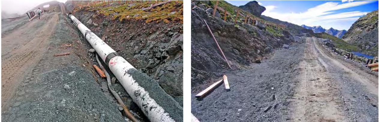
**Fig. 16** - In alto a sinistra la condotta forzata è stata appena posizionata nella trincea che fiancheggia la pista di servizio.
