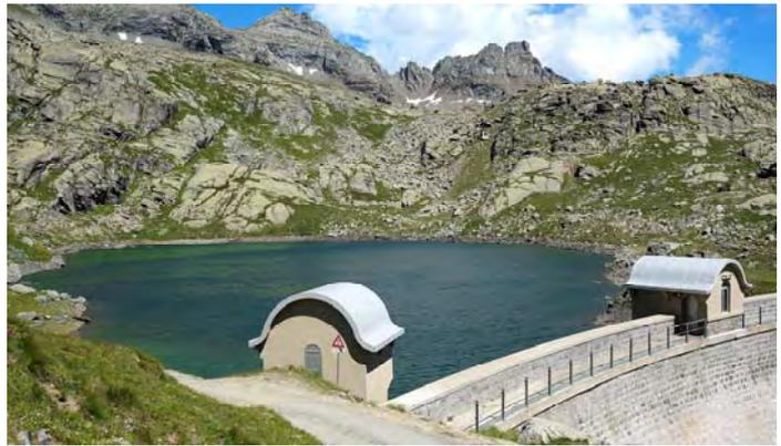
**Fig. 5** - i due bacini che consentono il funzionamento dell'impianto idroelettrico anche con il sistema del pompaggio. A monte (a sinistra) è il più vasto **Lago della Rossa** (2.716 m s.l.m.). A valle (a destra) il più modesto **Lago Dietro la Torre** (2.376 m s.l.m.).
