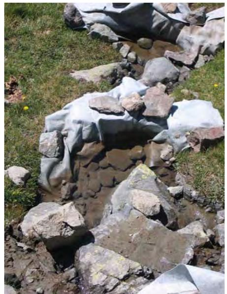
**Fig. 22** - La realizzazione di piccole vasche di decantazione mediante materiali poveri è risultata molto efficace al fine di evitare l'intorbidimento delle acque del rio Gurie da parte del cantiere (**3**) sviluppato sul versante sinistro del vallone.
