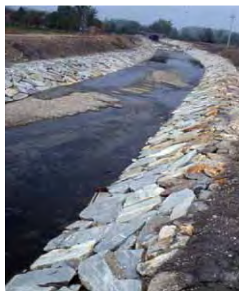
Fig. 12 - A sinistra un corso d'acqua ricco e diversificato. A destra lo stesso dopo una sistemazione idraulica. Un ecosistema fluviale è stato trasformato in un canale privo di vita ed idrogeologicamente più pericoloso: aumenta la velocità di corrente dell'acqua di piena (ed anche la sua energia erosiva), meno ostacolata nel suo fluire verso valle.
