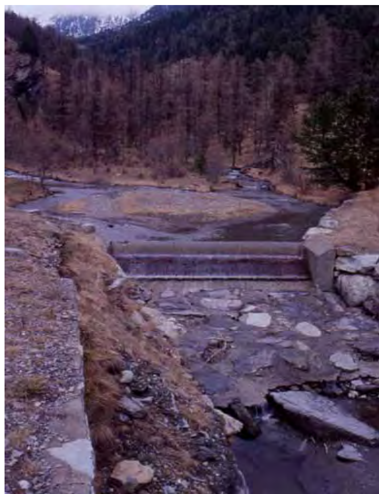
Fig. 37 - Le traverse per le derivazioni idriche (nell’immagine a lato per fini idroelettrici), come le briglie, costituiscono interruzioni della continuità biologica longitudinale. Tali opere vanno minimizzate mediante la realizzazione dei passaggi artificiali per l’ittiofauna e devono garantire i cosiddetti deflussi minimi vitali, cioè le portate minime di garanzia per mantenere i processi naturali degli ecosistemi fluviali. In molti casi invece, immediatamente a valle, i letti fluviali vengono letteralmente prosciugati.
