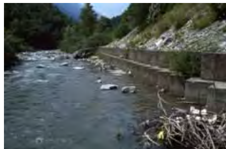
Fig. 21 - Esempi di difese spondali. A sinistra la sponda è stata "sistemata" mediante la realizzazione di una massicciata, su un tratto del fiume ad andamento quasi rettilineo e quindi in assenza di evidenti fenomeni erosivi; a ciò si aggiun-
