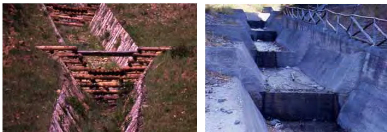
Fig. 36 - A sinistra è una briglia realizzata con le tecniche dell'ingegneria naturalistica, cioè mediante l'utilizzo di materiali naturali di scarso impatto visivo; assai efficace nel ridurre la velocità dell'acqua. In questo caso si tratta di un intervento realizzato su una incisione interessata dalla presenza di acqua in occasione di piogge prolungate o di rovesci più o meno intensi; con tale sistema di cerca di ridurre l'erosione dei versanti. A destra un sistema di briglie e scivoli in cemento per ridurre l'erosione di un torrentello, ma che genera inevitabilmente un incremento della velocità dell'acqua; quando tale sistema è diffusamente utilizzato si contribuisce ad accelerare il trasferimento dei flussi idrici a valle, cioè l'obiettivo opposto rispetto a quanto si vuole ottenere per il controllo del dissesto idrogeologico. Infatti è importante aumentare il tempo di corrivazione 7 , anziché ridurlo.
