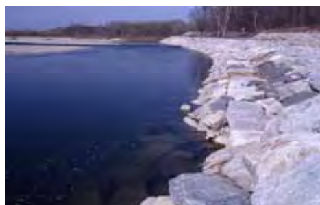
Fig. 21 - Esempi di difese spondali. A sinistra la sponda è stata "sistemata" mediante la realizzazione di una massicciata, su un tratto del fiume ad andamento quasi rettilineo e quindi in assenza di evidenti fenomeni erosivi; a ciò si aggiun-
